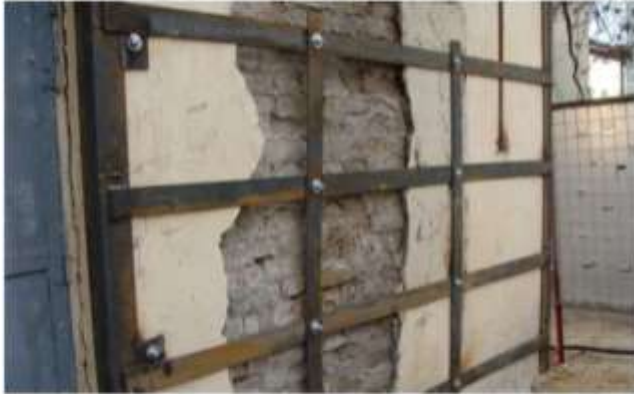
Підсилення деформованої цегляної стіни сталевими накладками
