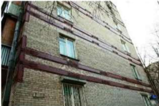
Підсилення деформованої цегляної стіни сталевими накладками
