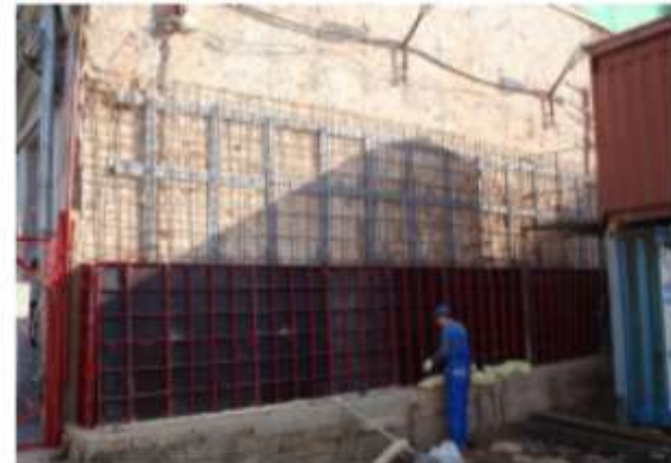
Підсилення деформованої цегляної стіни обіймою із арматури
