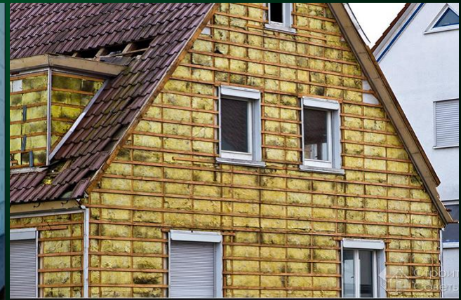
Метод утеплення стін теплопанелями з мінеральної вати
