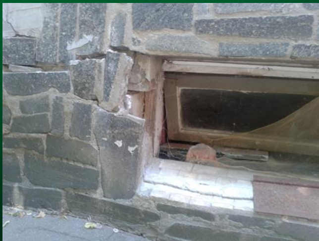
Порушення в теплоізоляції в корпусі №7
