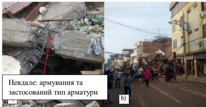
Рис. 7. Не достатня несуча спроможність арматурних каркасів
