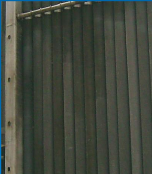
Забруднення системи охолодження трансформаторним маслом
