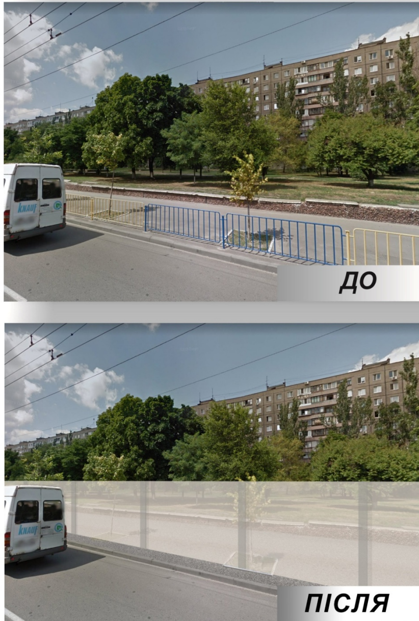
Рисунок 3 Приклад встановлення екрану на пр. Слобожанський уздовж рекреаційного об'єкту для захисту від шуму
