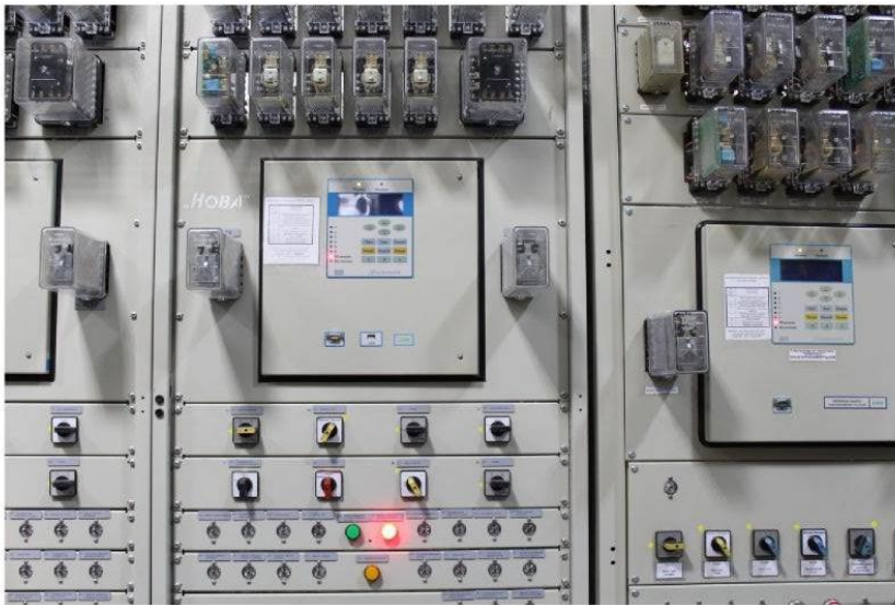
Панель мікропроцесорного захисту ПМ Р3А «Діамант»
