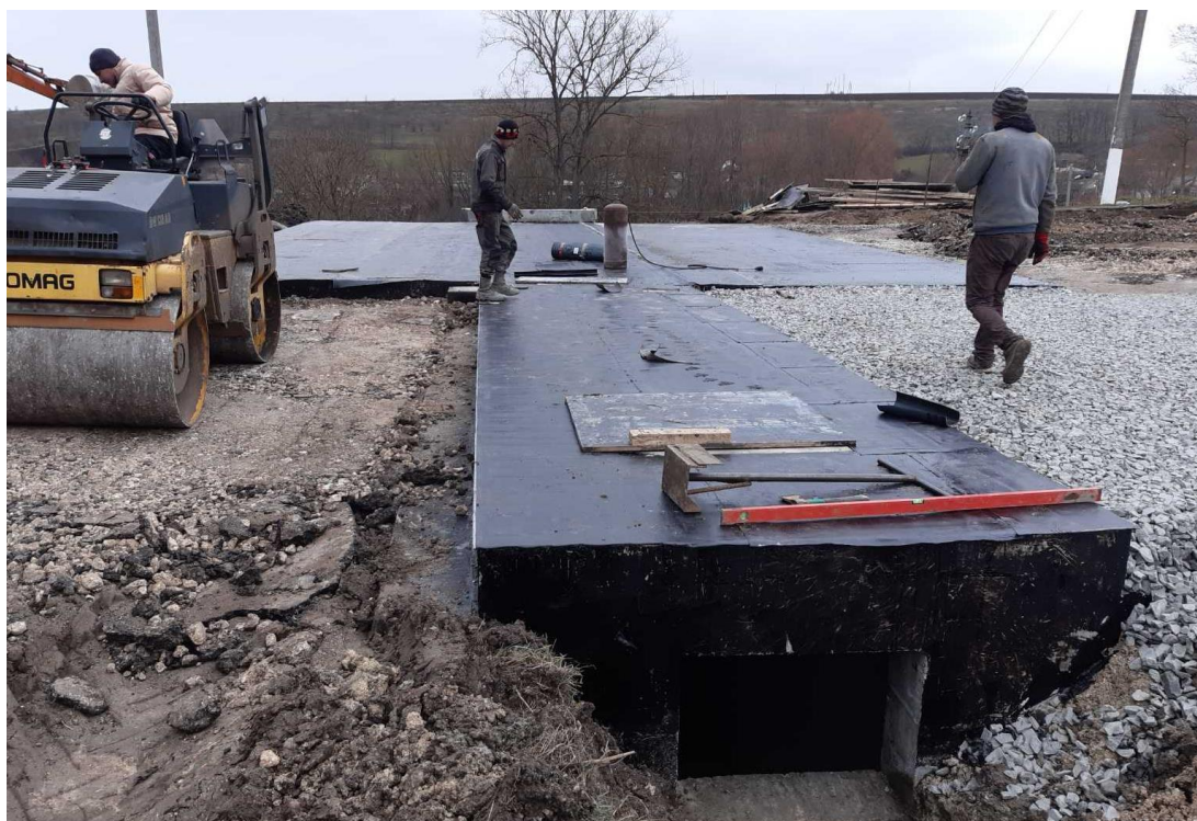
Рис. 16. Завершальний етап будівництва тунелю в момент улаштування горизонтальної гідроізоляції та підготовки основ дорожнього одягу (вид з боку, протилежного водоскидному отвору).
