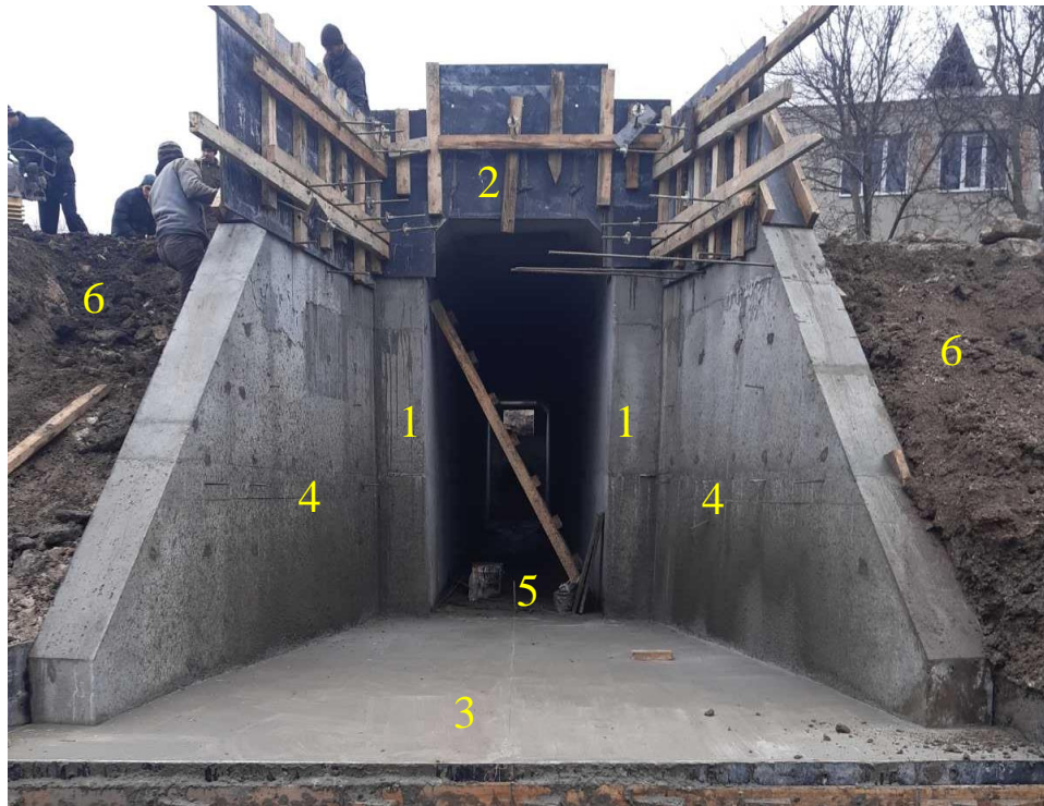
Рис. 3. Загальний вигляд комбінованої споруди тунельного типу з боку водоскидного отвору на автодорозі місцевого значення С-02-09-04 у с. Джугастра Крижопільського району Вінницької області. Тут: 1 – опорні стінки тунелю, 2 – верхня плита тунелю, 3 – водоскидна плита, 4 – відкритки, 5 – плита днища тунелю, 6 – земляний насип.
