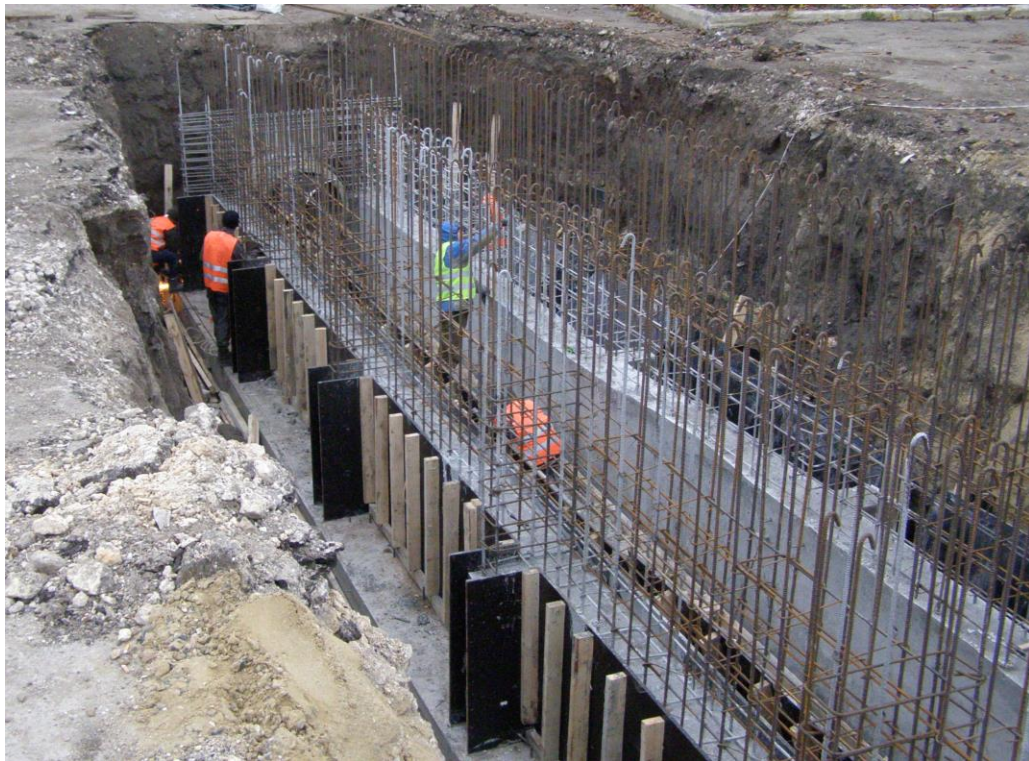
Рис. 15. Армування конструкцій тунелю просторовими каркасами.
