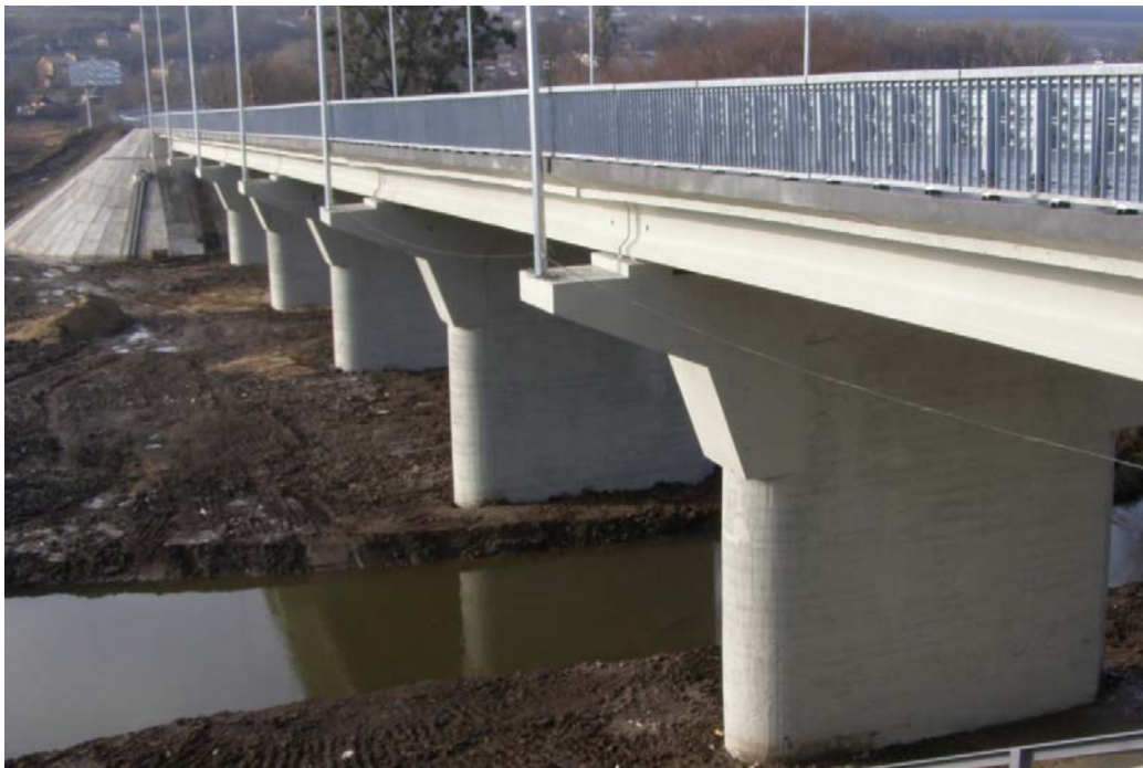
Рис 3. Загальний вигляд мостової опори після реконструкції.
