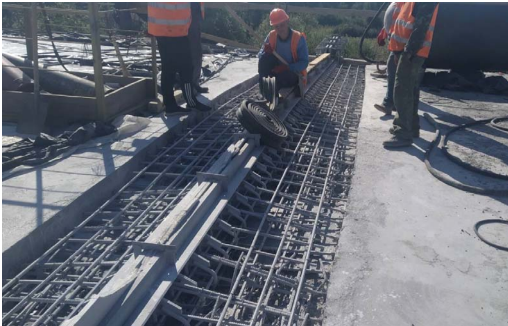
Рис 2. Монтаж металоконструкцій деформаційного шва Mauer на мостовій споруді у м. Гайсин.
