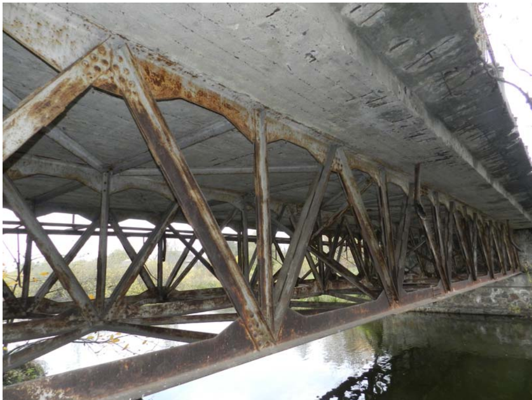
Рис. 3. Конструкція прогонової будови мосту на дорозі Р-33 у смт. Дашів у вигляді просторової ферми з накладною двохконсольною залізобетонною плитою (вид знизу).
