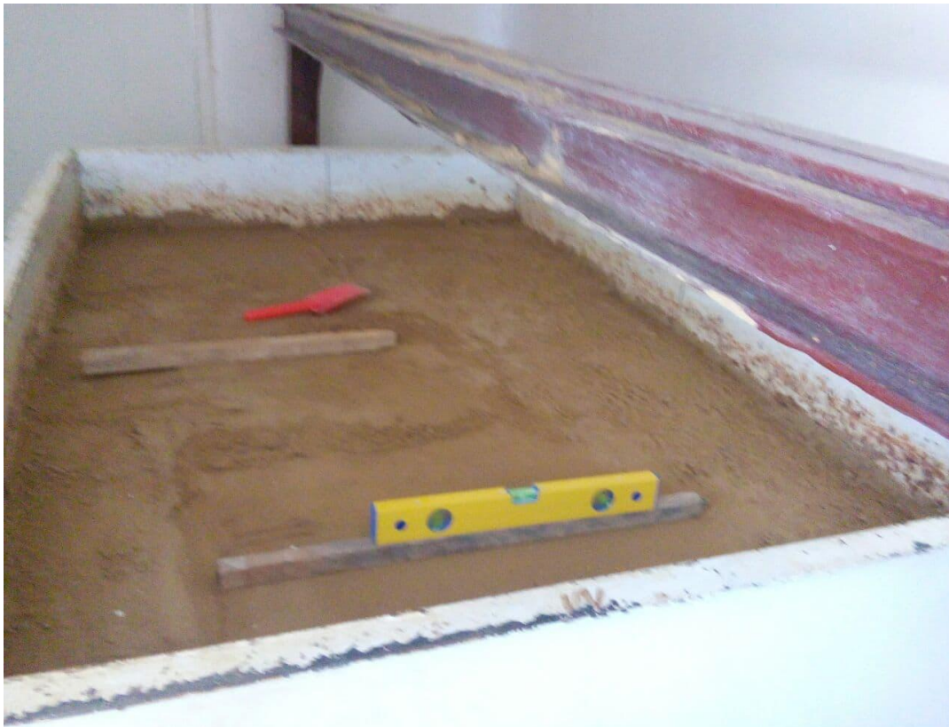
Рисунок 4. Вирівнювання поверхні під фундамент
