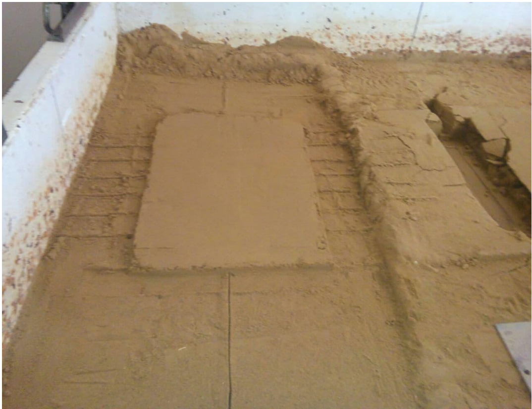
Рисунок 3 Влаштування компенсаційного прошарку ґрунту
