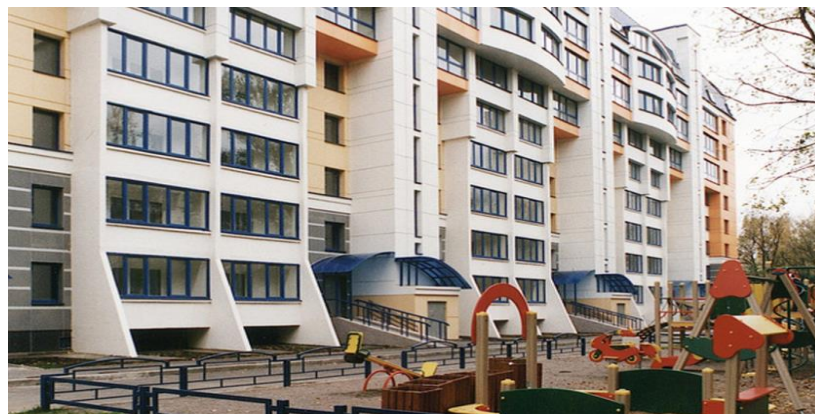
Рисунок 3. Надбудована хрущовка із зовнішнім каркасом, Москва
