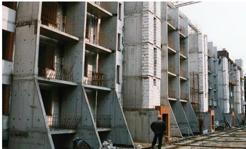
Рисунок 2. Нарощування зовнішнього каркасу на хрущовці, Москва
