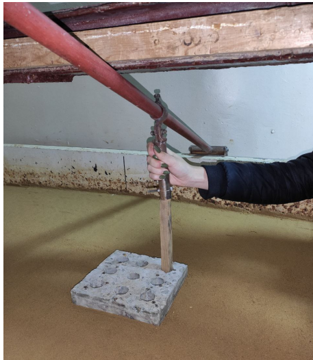
Рис. 2.35 – Вдавлювання паль за допомогою важільної системи
