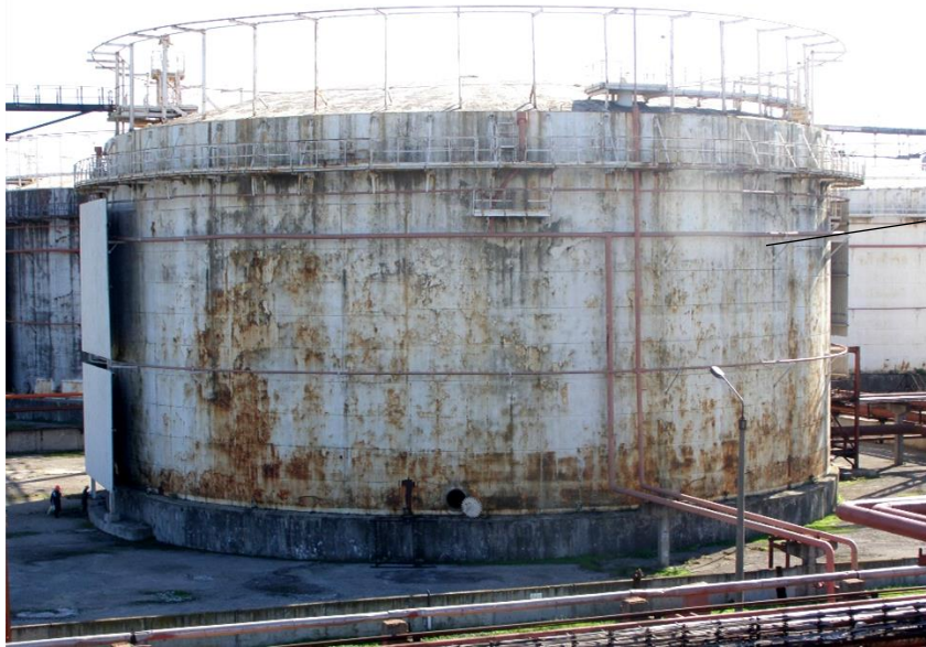
Рис. 1. Типовий великорозмірний резервуар для зберігання метанолу на одному з підприємств хімічної промисловості України. Зовнішній вигляд і стан
