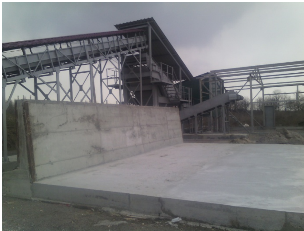
Рисунок 2.1 – Загальний вигляд сортувальної станції м. Калинівка
