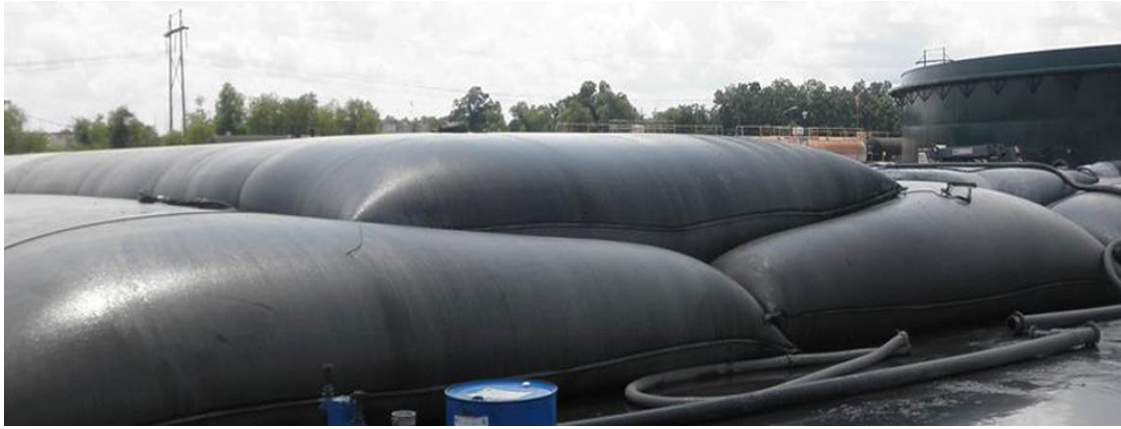
Рисунок 5 - Зневоднення та зберігання річкового мулу у геотубах.
