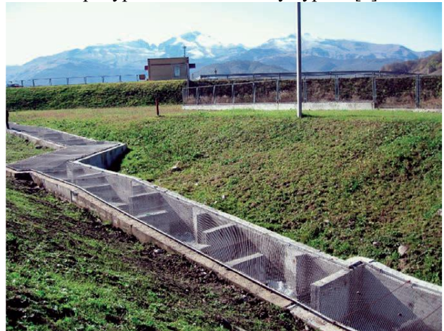
б) Сходовий рибохід Аушигерського гідровузла на річці Черек в Кабардіно-Балкарській республіці РФ.
