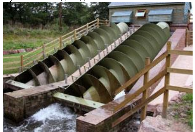
Рисунок 20 – Зовнішній вигляд шнекової турбіни
