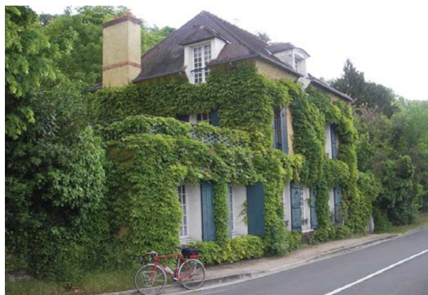
Рис. 5 – Вертикальне озеленення фасадів будівлі
