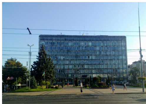
Рис. 3. Агресивне візуальне середовище. Будівля Вінницької міської ради.
