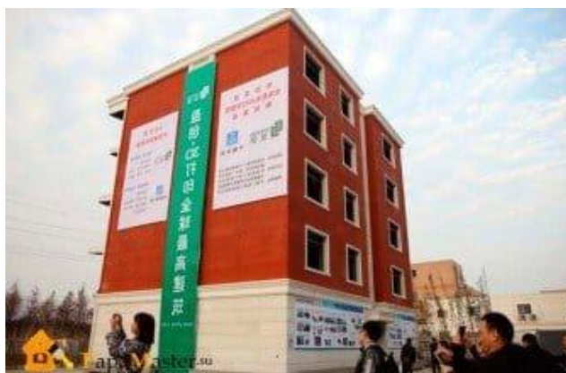
Рис. 2. Виставка у Цзянсу( Китай). Компанія молодих ентузіастів під назвою Win Sun налагодила серійне виробництво будинків, зведених зусиллями гігантського 3D-принтера
