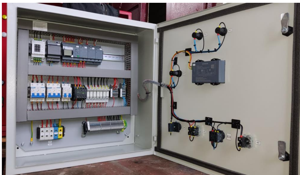
Рис. 3. Зовнішній вигляд щита керування пальником Riello RS-300/M BLU
