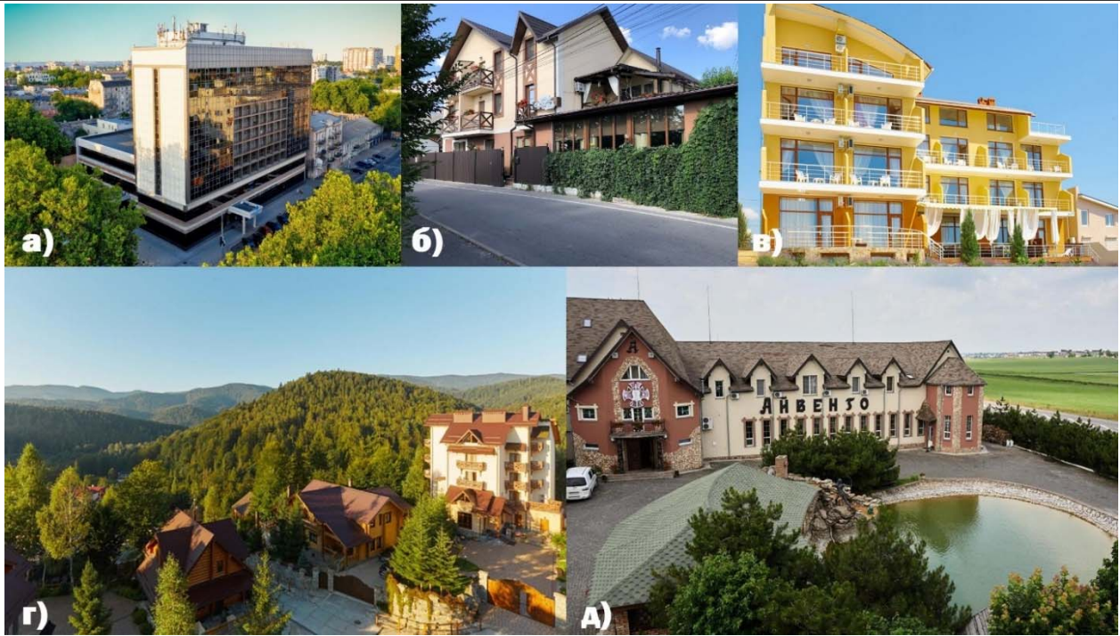
а) – готель «Black Sea Central», м. Одеса; б) – готель «Квітень», м. Вінниця; в) – готель «Villa Lavanda» біля Одеси; г) – готель «Ведмежа гора Family Resort & Spa», Яремче; д) – готельно-ресторанний комплекс «Айвенго», траса Київ-Чоп.
