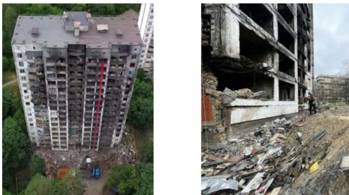
Рисунок 4 – Пошкодження багатоквартирного великопанельного будинку серії БПС по вулиці Чорнобильській, м. Київ
