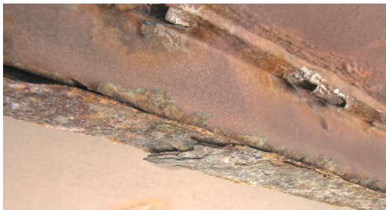
Рисунок 4 – Типовий технічний стан балок настилу. Шарувата, місцями наскрізна корозія нижньої полицки, поверхнева корозія стінки та верхньої полицки
