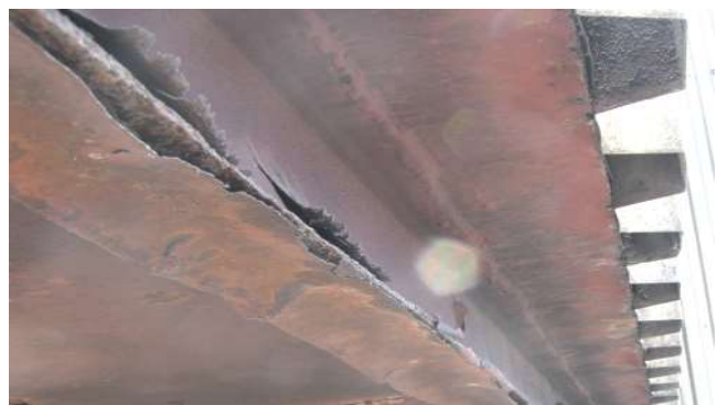
Рисунок 3 – Стан фрагменту головної повздожньої балки днища. Виразкова корозія зовнішнього краю нижньої полицки двотавра
