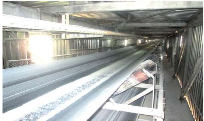
Рисунок 2 – Загальний вигляд галереї зсередини
