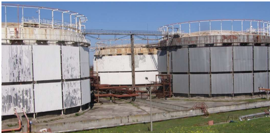
Рисунок 1 – Загальний вигляд складського комплексу з чотирьох великорозмірних ємностей з південного боку а, також, жалюзійних екранів та системи сервісних перехідних містків.
