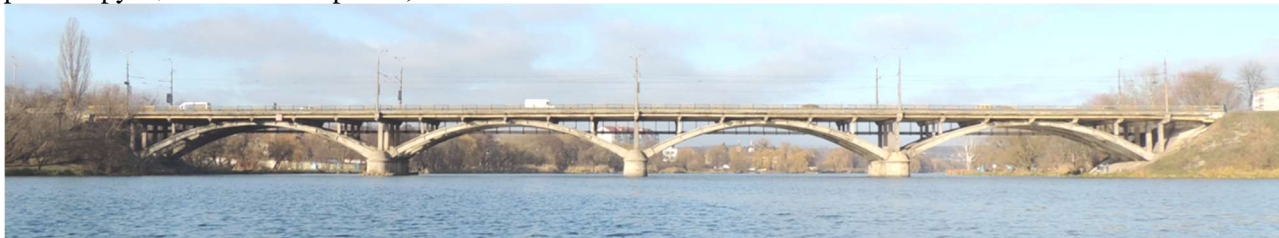
Рисунок 1 – Загальний вид мосту по вул. В. Чорновола
