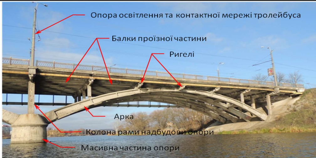
Рисунок 2 – Загальний вид конструкцій арочної прогонової будови мосту по вул. В. Чорновола
