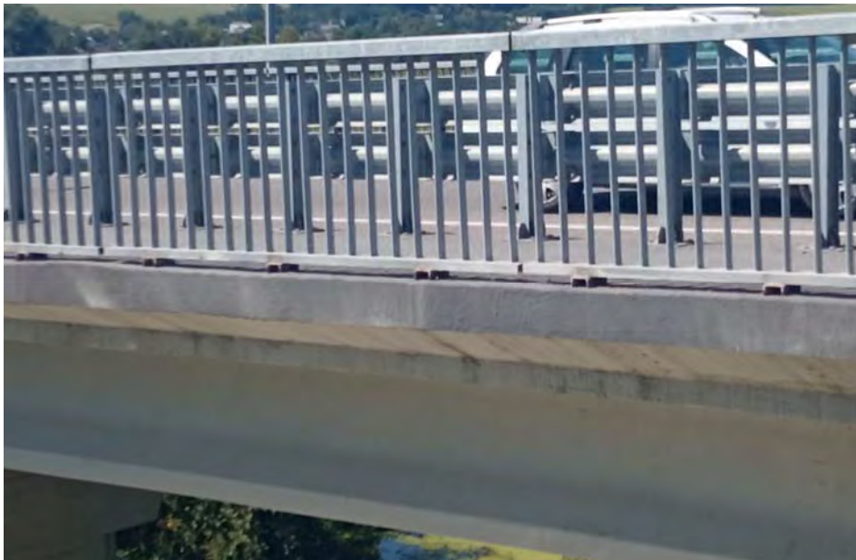
Рис. 5. Зовнішній вигляд балочної пролітної будови мосту через р. Сіб, м. Гайсин після реконструкції, в тому числі, після підсилення тротуарної частини полігональною накладною плитою.
