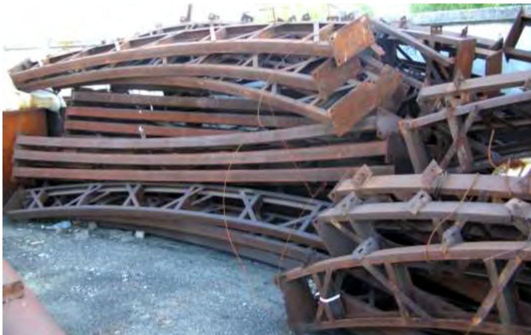
Рис. 2. Відправні елементи (секції) безшарнірних арок з розібраних складів сільськогосподарського призначення, що були у використанні.
