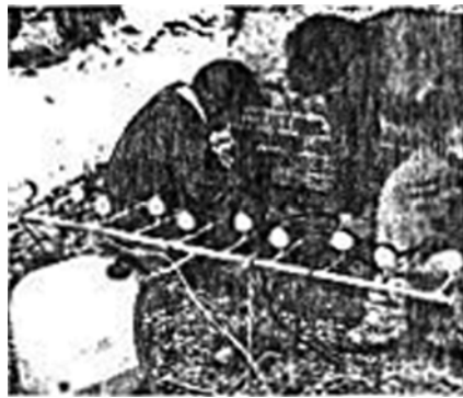
Рис. 41. Улаштування гідроізоляції стіни методом ін'єкціювання
