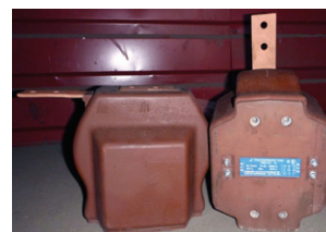
Рис. 3. Зовнішній вигляд трансформатора струму типу ТЛМ-10
