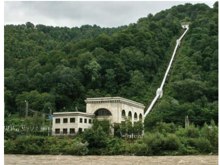
Схема ГЕС з напірною деривацією
