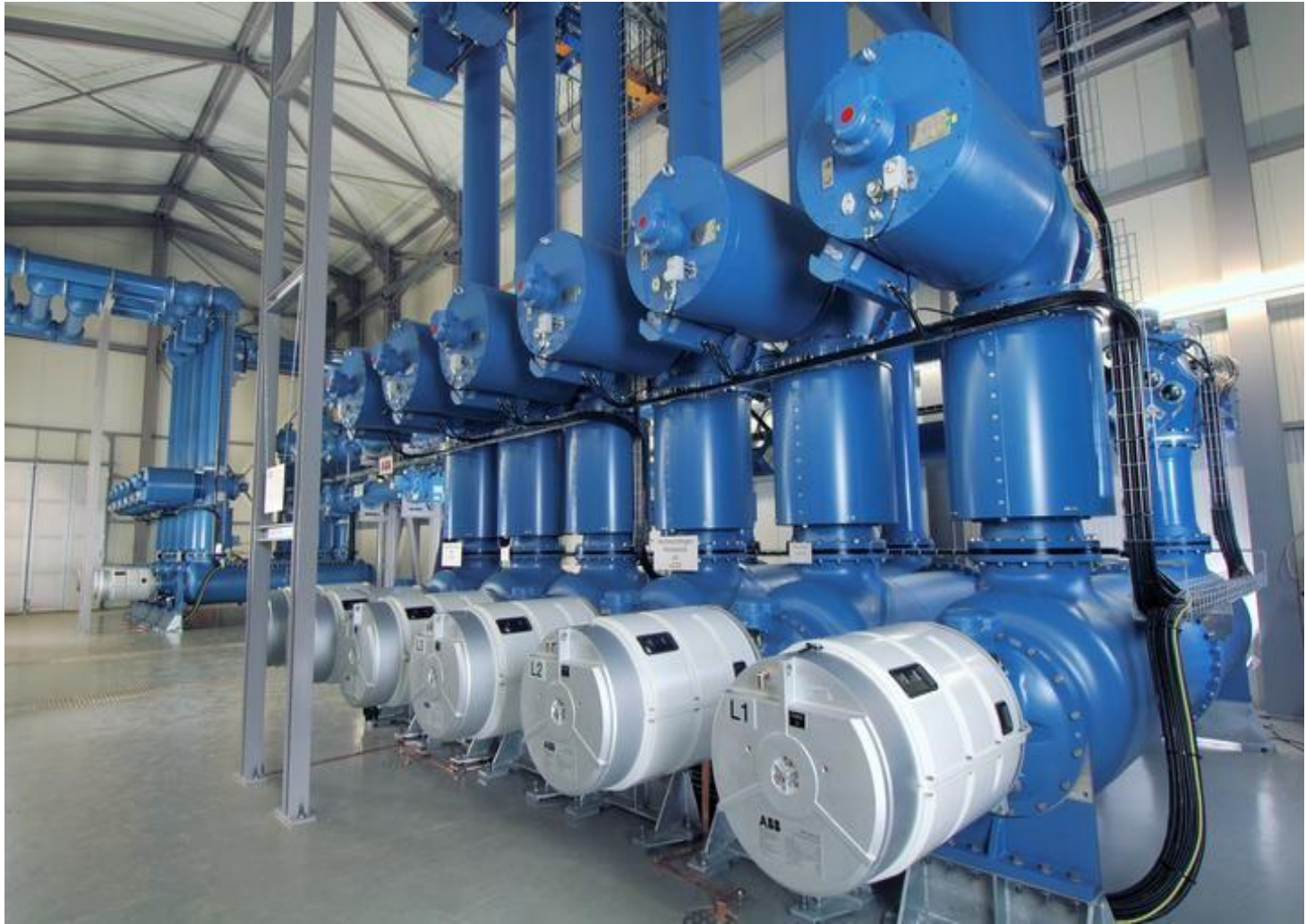
Рисунок 4 - КРУЕ до 550 кВ серії ELK3 (ABB)
