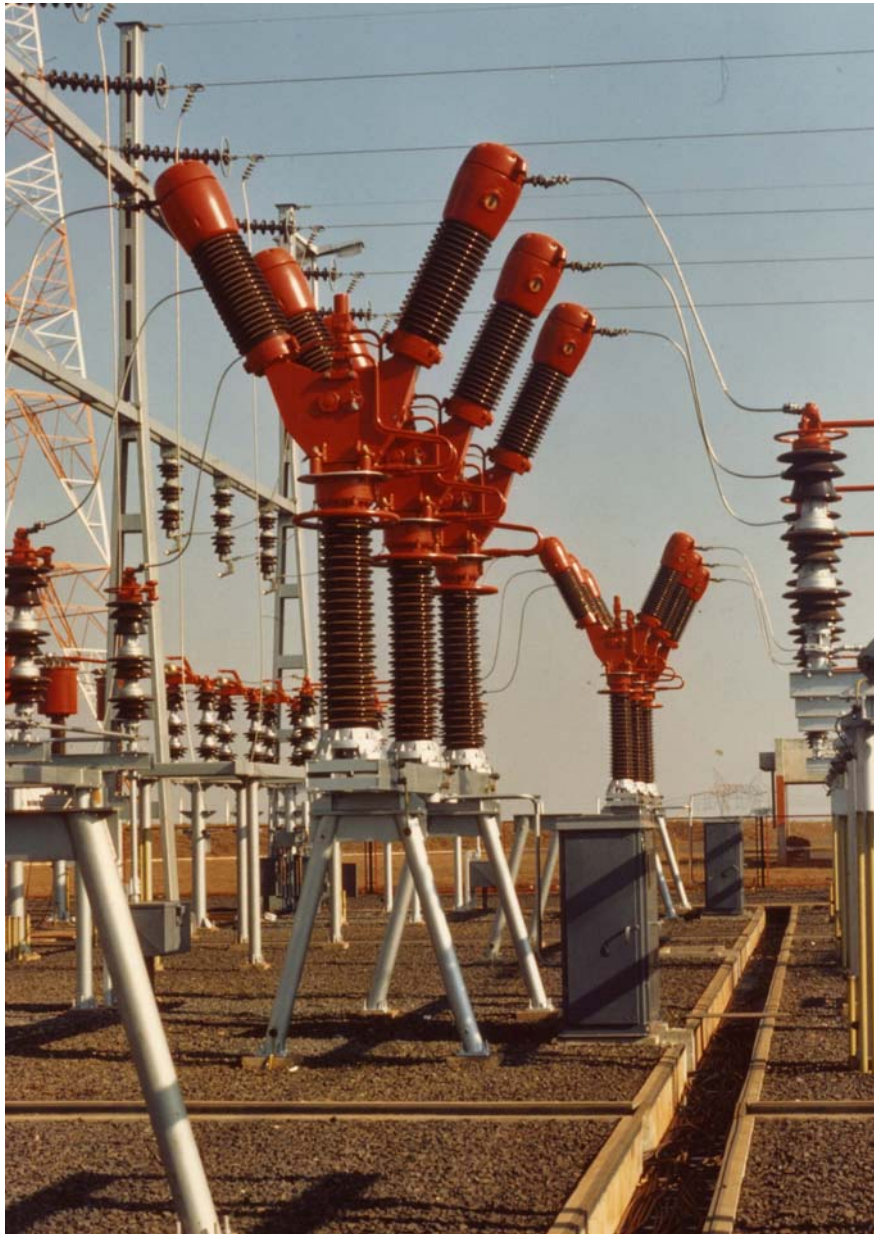
Рисунок 4.6 – Загальний вигляд вимикача МГ-110
