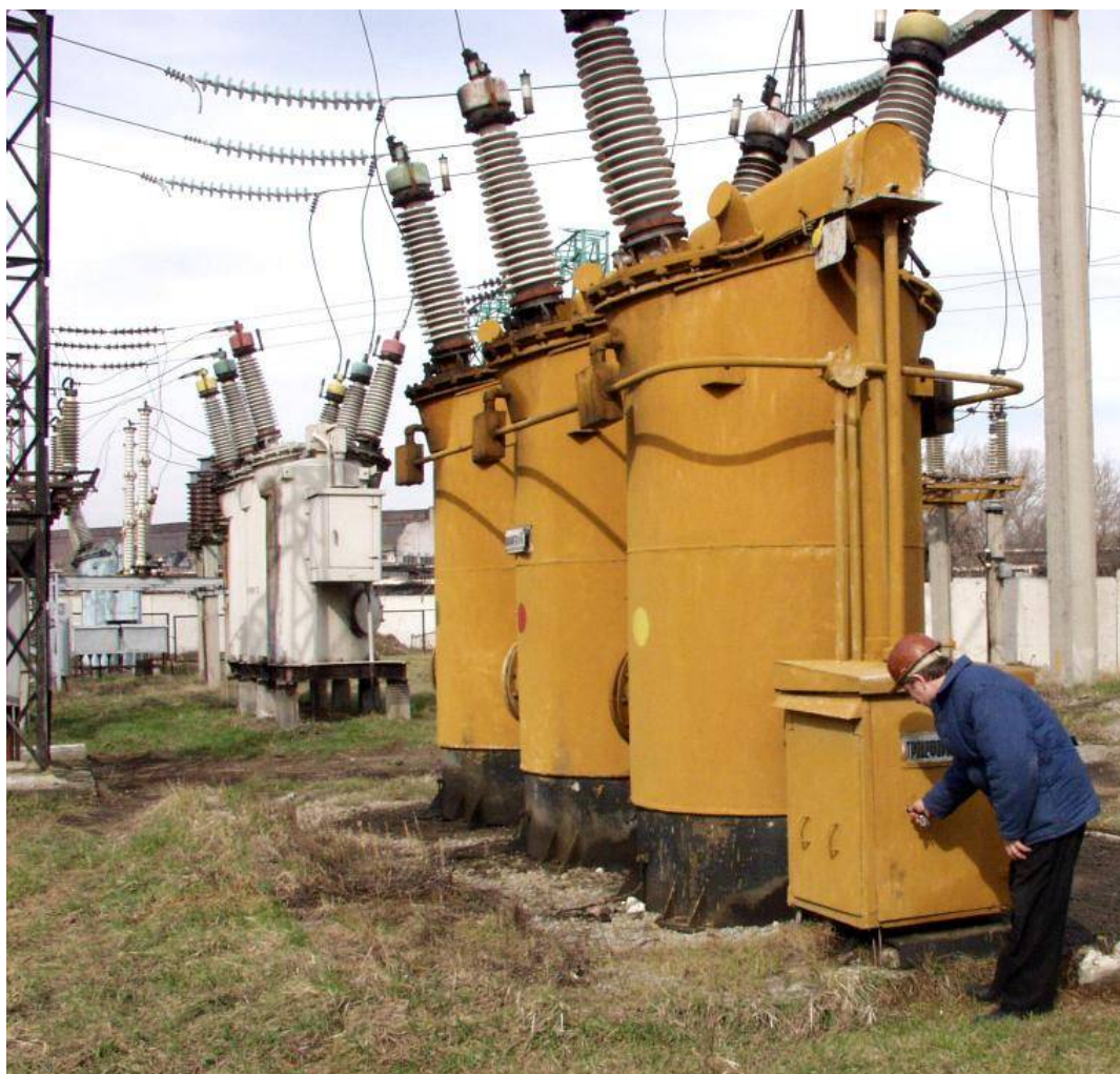
Рисунок. 2.9 - Загальний вигляд вимикача типу У-220-2000-50/У1
