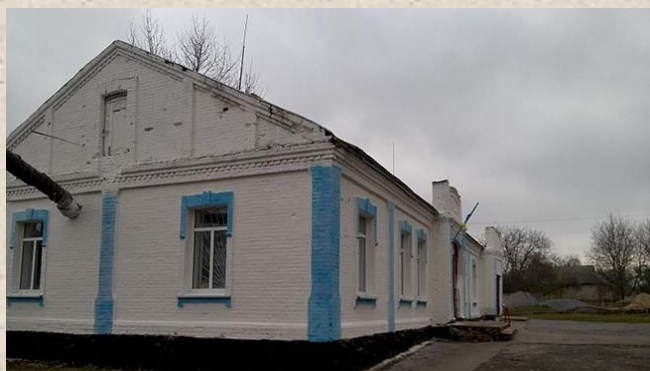
Будівля Новоприлуцької школи, де колись був хедер, в якому навчався Зельман Ваксман
