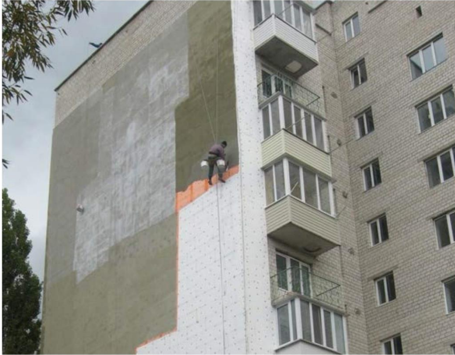
Сучасний вигляд фасаду після утеплення пінопластом
