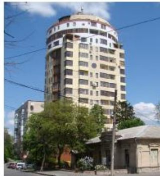
Вул. Л. Толстого
