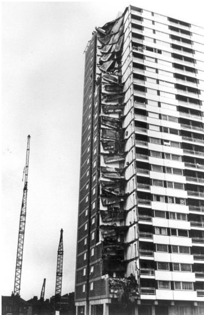
Будівля Ronan Point (Лондон) після обвалення кута будинку, 10 травня 1968 року
