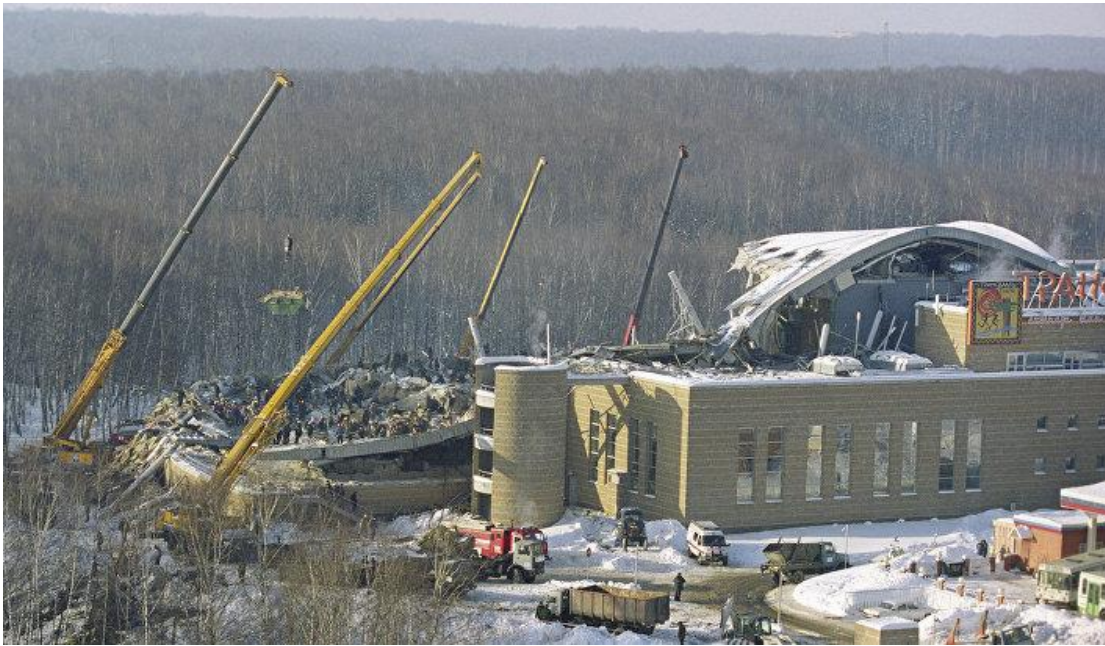
Руйнування спортивно-розважального комплексу Трансвааль-парк, 14 січня 2004 року
