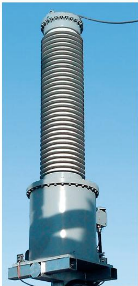
Газонаповнений трансформатор напруги для AIS 145 кВ
