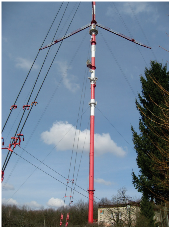
Рисунок 2 – Антена РПА-2П-2, встановлена на позначці +107,5 м
