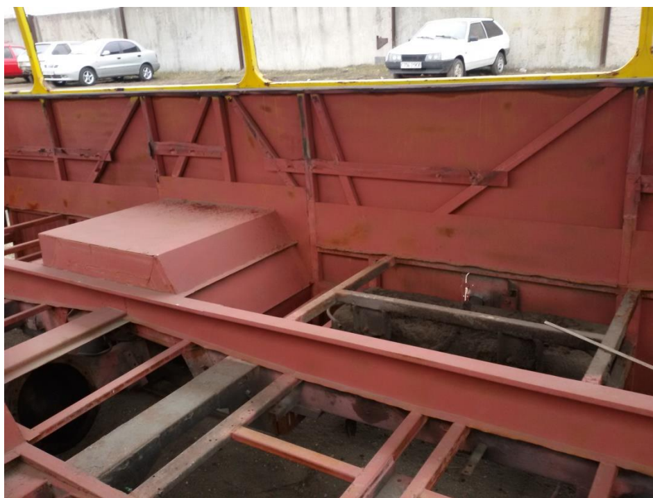
Рисунок 3 – Вигляд каркасу кузова автобуса «Богдан А-092» після ремонту
