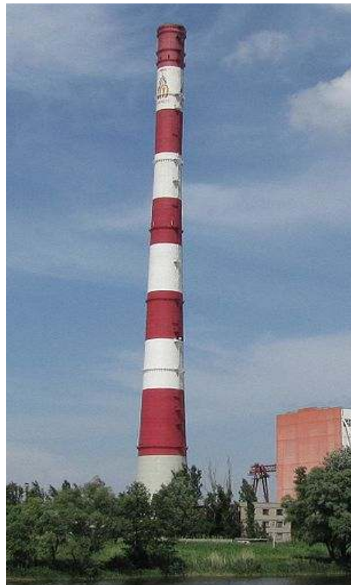
Рисунок 1 – Конструкція залізобетонної димової труби: а – конструктивна схема труби, б – реальна висотна димова труба Харківської ТЕС з залізобетонним стволом
