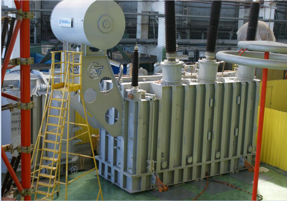
Рисунок – Трансформатор напруги типу ТДЦ-125000/110
