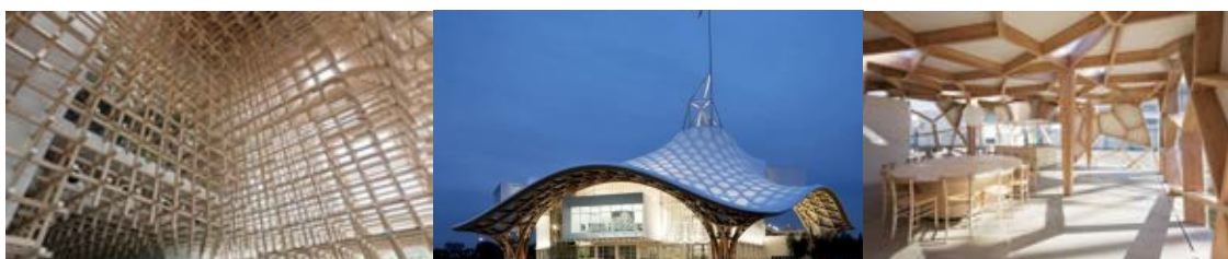
Рис. 1. Вигляд каркасної будівлі
