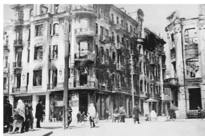
Зруйновані будівлі на вул. Леніна (сучасна вул. Соборна), 1944 р. (ВОКМ. Ф. 1626. Кв. 12634)
