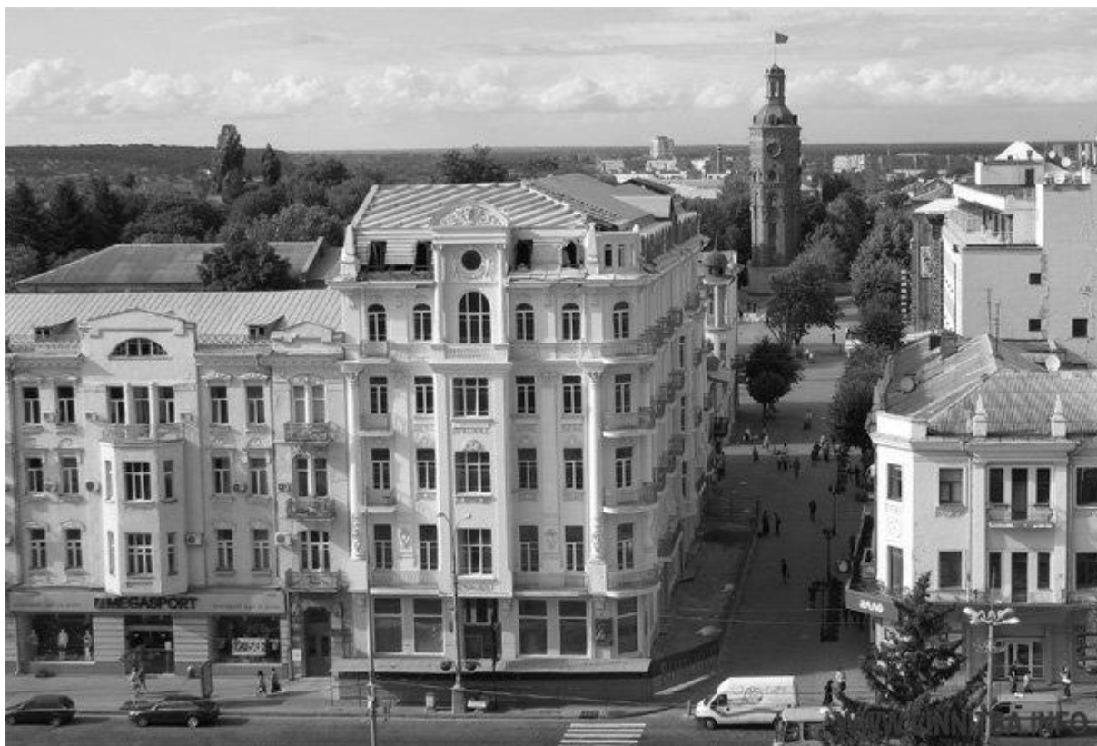
Рис. 3 Готель «Савой» під час реконструкції, 2014р.
