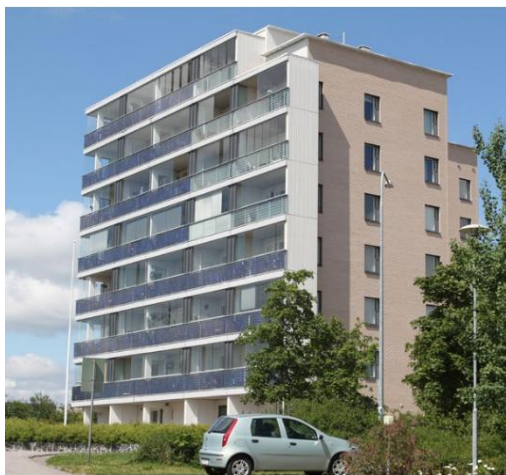
Рисунок 1 – Встановлення фотоелектричних панелей на балконах багатоповерхових будинків
