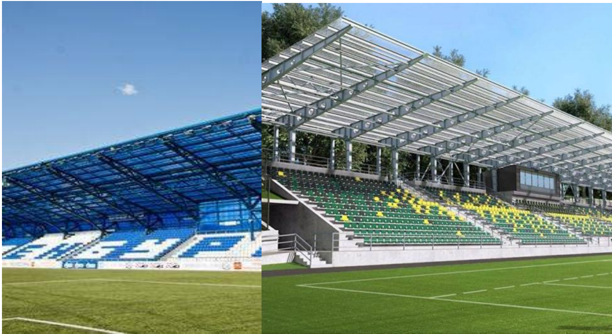
Рис. 1. Різновид покрівлі стадіонів із збірних металевих конструкцій
