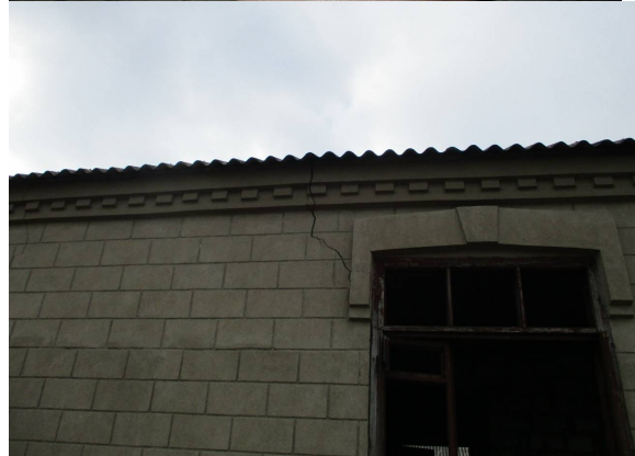
Рис. 3. Руїнування конструкцій та елементів будівлі внаслідок неправильної експлуатації, рельєфу місцевості, геологічної та гідрогеологічної ситуації та застосованих будівельних матеріалів. Житлові будинки в смт. Вапнярка
