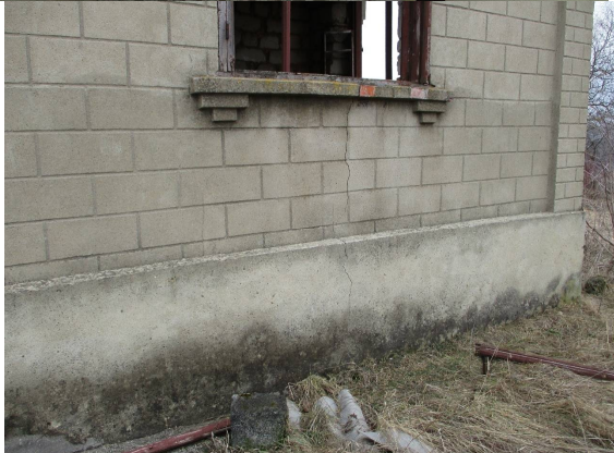
Рис. 3. Руїнування конструкцій та елементів будівлі внаслідок неправильної експлуатації, рельєфу місцевості, геологічної та гідрогеологічної ситуації та застосованих будівельних матеріалів. Житлові будинки в смт. Вапнярка
