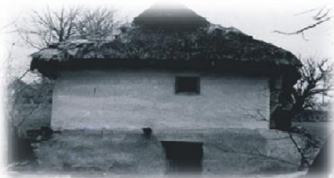
Рис. 2.5. Влаштування цокольного поверху
