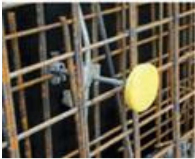
Рисунок Б.7 – Позначення фіксованих точок заземлення
