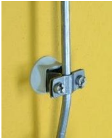
Рисунок А.20 – Кріплення струмовідводів до стіни
