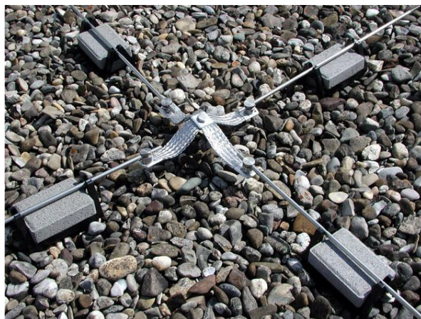
Рисунок А.13 – Різні приклади з'єднання провідників за допомогою компенсаторів температурного подовження
