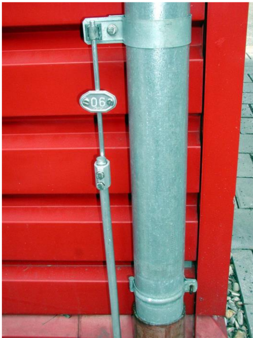
Рисунок А.22 – Використання природних компонентів у якості струмовідводу
