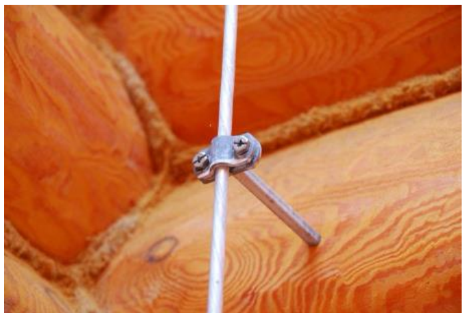
Рисунок А.21 – Кріплення струмовідводів на дерев'яну поверхню
