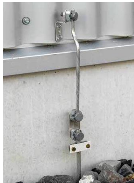
Рисунок А.19 – Приклади влаштування контрольних точок заземлення
