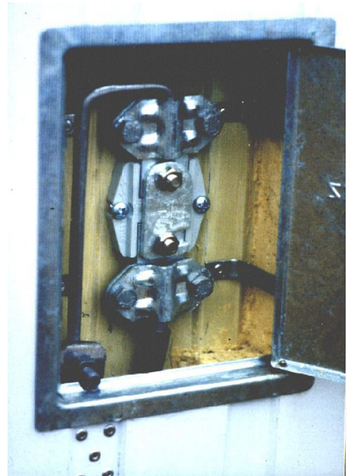
Рисунок Б.6 – Захист від корозії точки з'єднання струмовідводу та заземлювача; розміщення контрольної точки з'єднання у стіні
