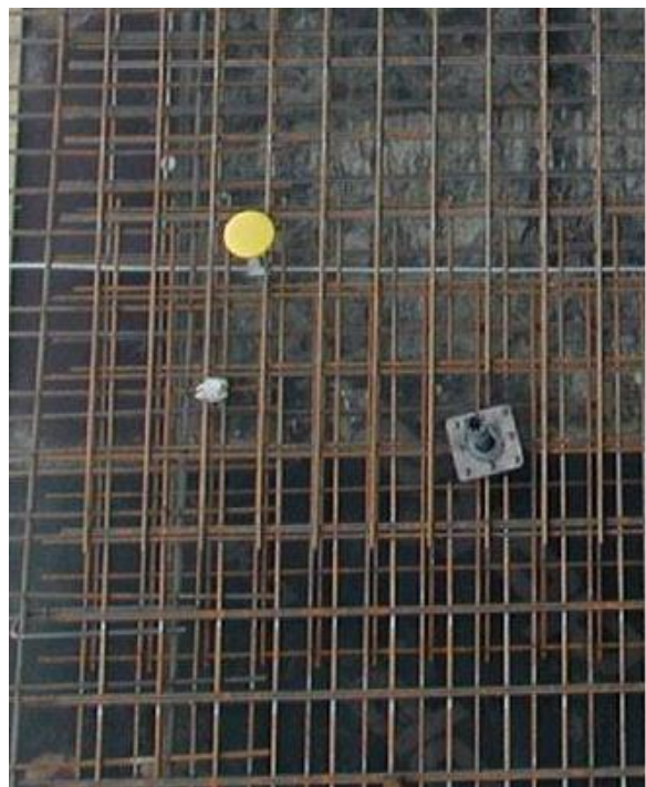
Рисунок Б.8 – Приклад прокладання провідників фундаментного заземлення типу В та з'єднання з арматурою
