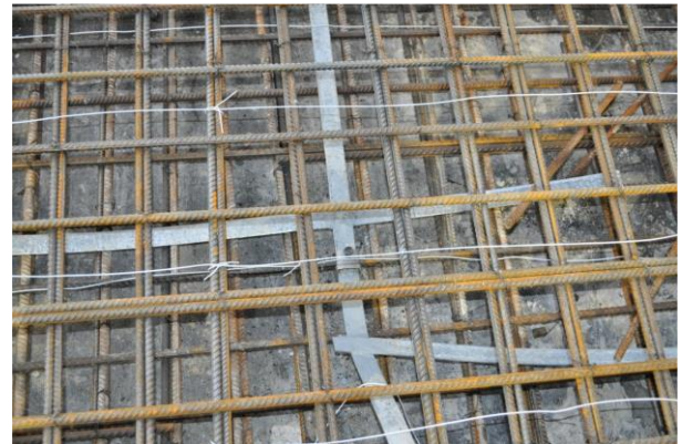
Рисунок Б.7 – Позначення фіксованих точок заземлення
