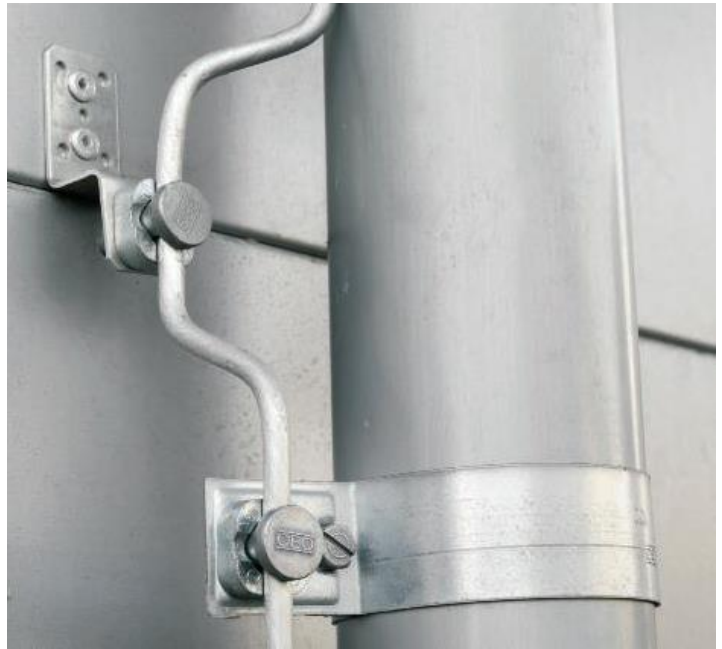
Рисунок А.22 – Використання природних компонентів у якості струмовідводу
