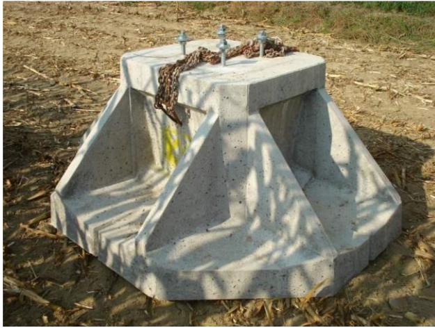
Рисунок А.6 – Бетонний блок та гвинтовий фундамент для кріплення блискавкоприймальної щогли висотою 10-30 м
