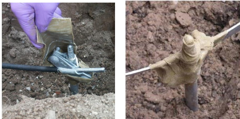
Рисунок Б.4 – Захист від корозії за допомогою антикорозійного бандажу
