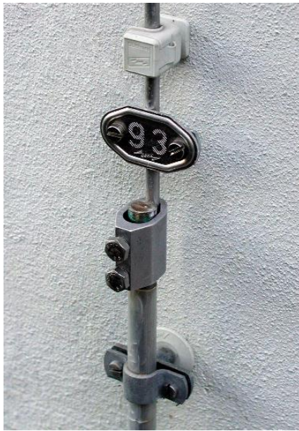
Рисунок А.19 – Приклади влаштування контрольних точок заземлення
