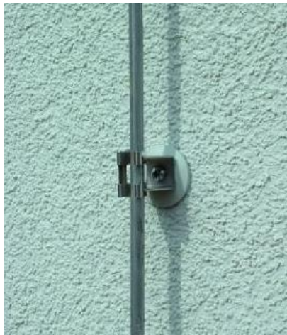
Рисунок А.20 – Кріплення струмовідводів до стіни
