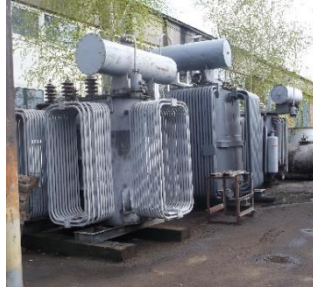
б) СТ 35 кВ до та після ремонту
